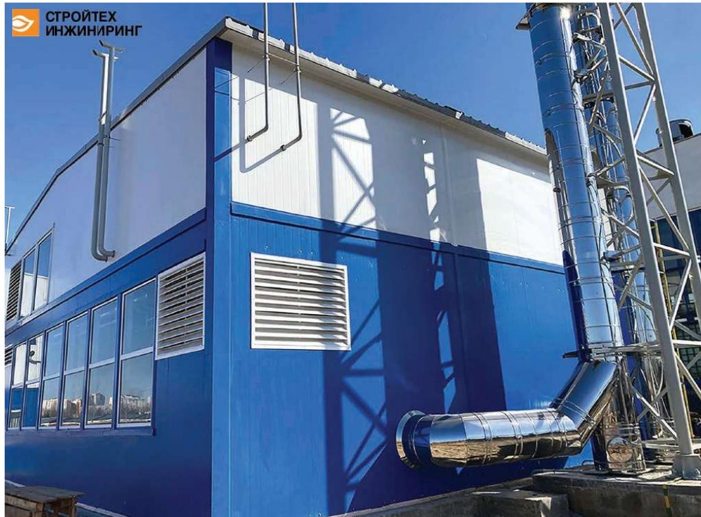
**Блочно-модульная котельная целиком собирается на площадях завода-изготовителя, внутри монтируется все основное и вспомогательное котельное оборудование**
